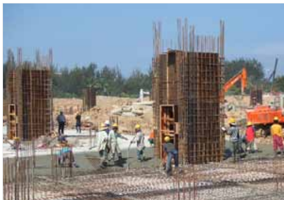
添加了KIM混凝土防水外加剂的混凝土浇筑底板
